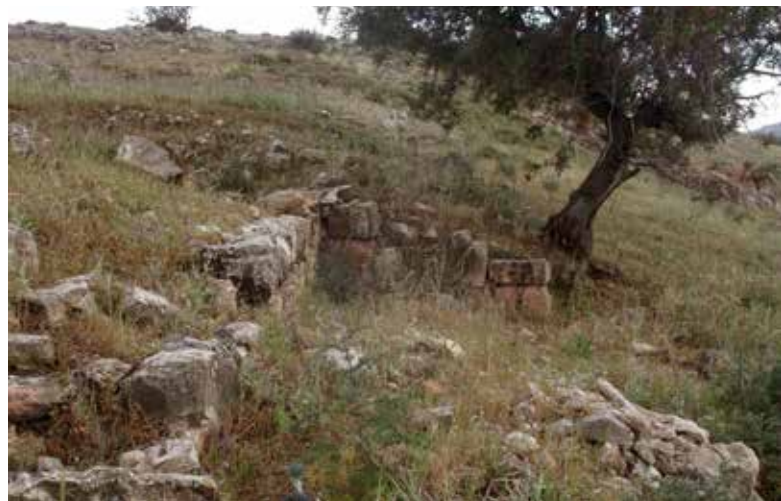
איור 8 | קטע חומה לפני שימור | צילום: אדר' ערן מרדכוביץ, 2014
